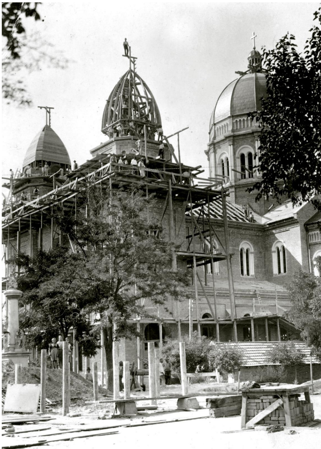
46. Kép. Készülnek a kistornyok, a tetőfedés is folyamatban van. Gubena Lacinak szemmel láthatólag nincs tériszonya.
