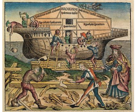
(Ábra 25. Nőé bárkájának építése)
